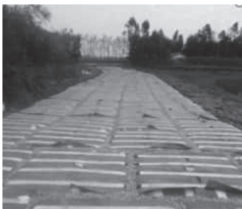
图 6.3.1-1 地固件铺设完成状态图
