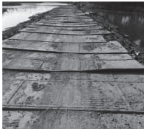
6.3.1-2 地固件铺设钢板后状态
