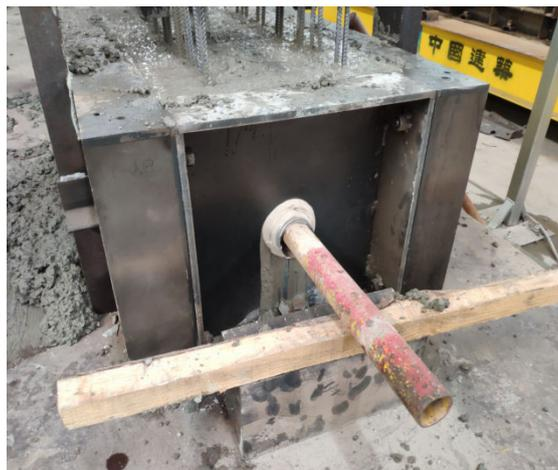
图 12 预制梁预应力孔道内穿钢管
