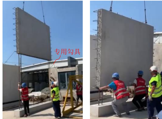
图 15 预制空心墙板边缘构件竖向受力钢筋对位作业照片
