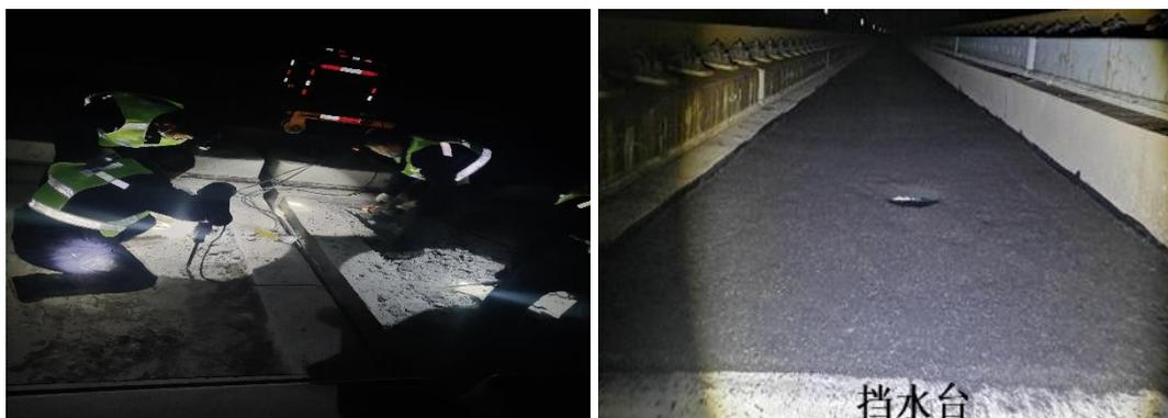
说明图 6.3.4 桥梁梁端挡水台凿除及乳化沥青混凝土施工效果
